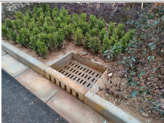
地下管网雨水口
