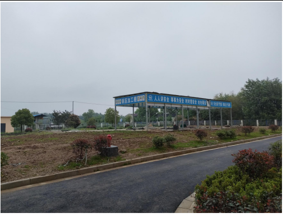
施工生产区（一期建设范围内）
