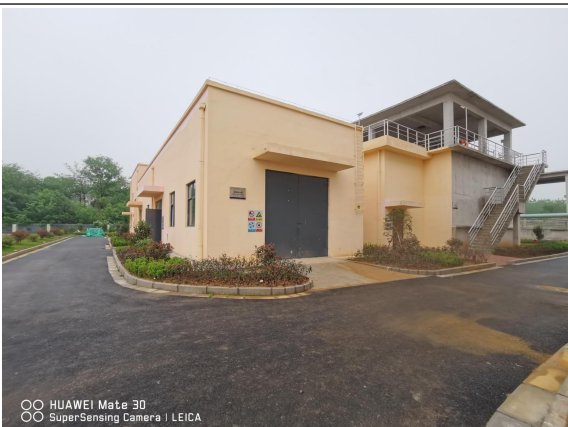
建构筑物已完成
