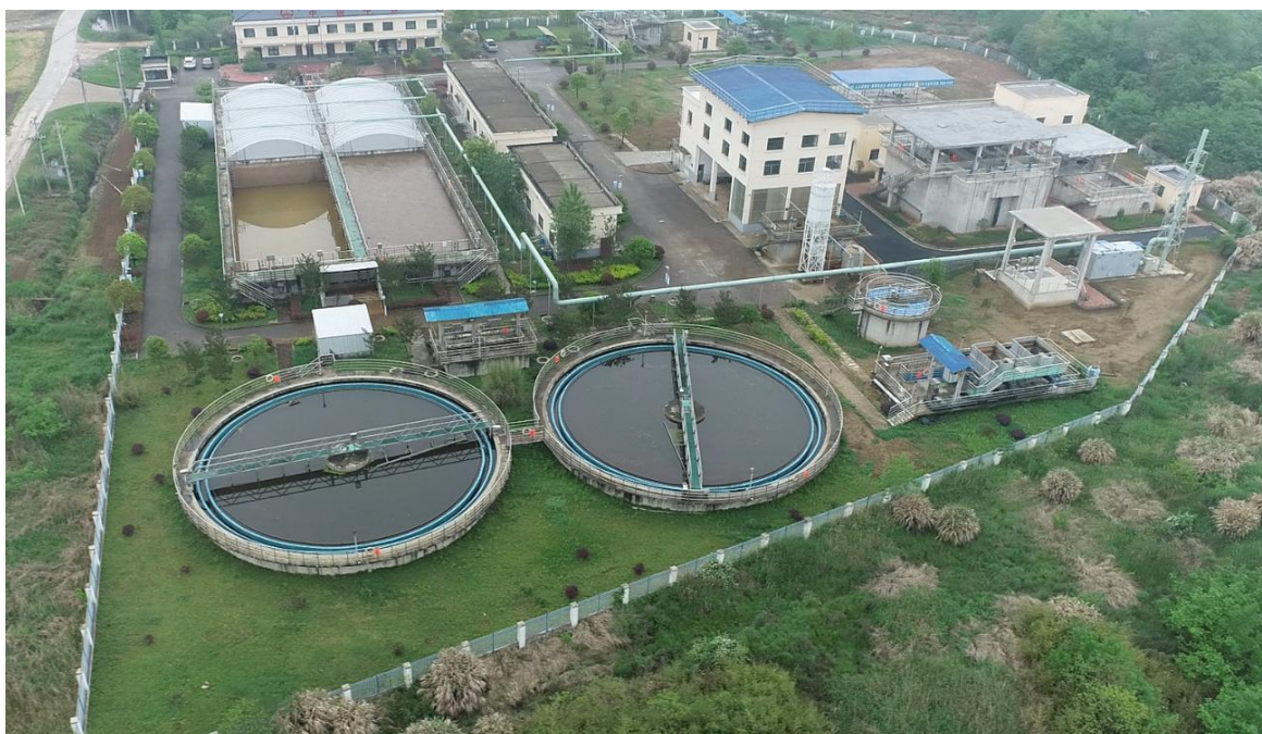
图 1.2-2 工程现状建设情况
